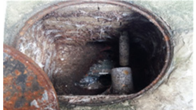
가로수 뿌리로 인한 하수관로 침투
