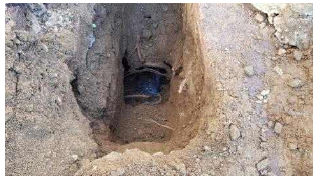
가로수 뿌리로 인한 하수관로 침투
